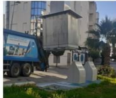
(40) Conteneurs enterrées 3000 L
