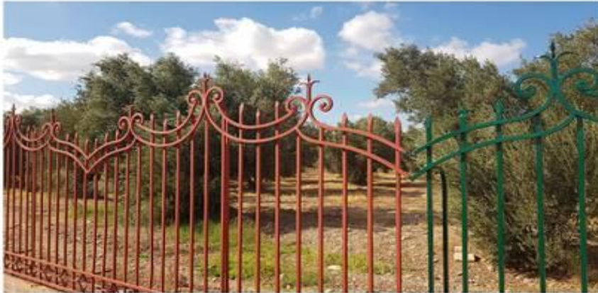
Traitement primaire antirouille
