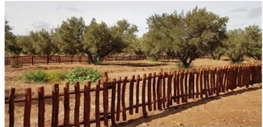
Barrières : travaux en cours
