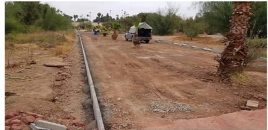
Travaux de pose de fond de forme et bordures
