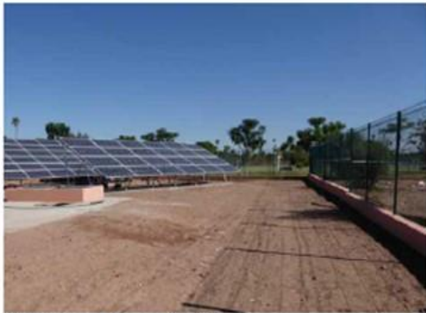
Plateforme des puits clôturée
