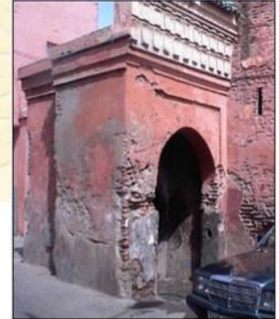
Fontaine Bab Ailane avant sa restauration
