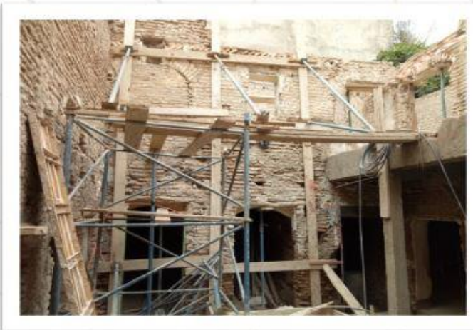
عملية إعادة البناء
