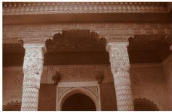
صورة سقف خشبي للمس المحيكة بالبناء
